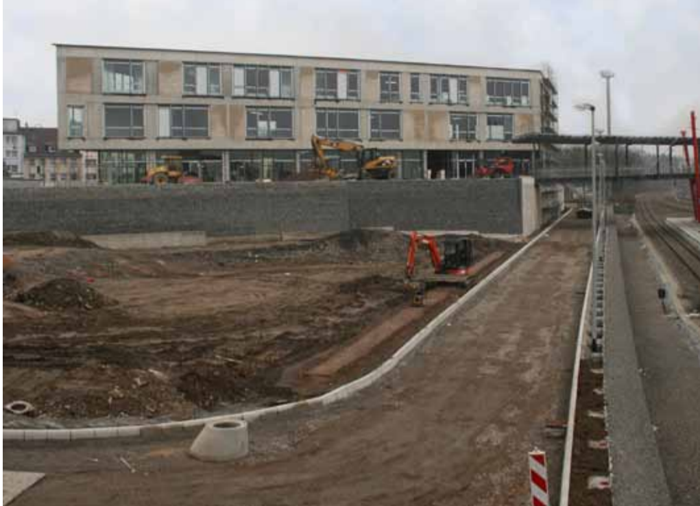
Im Vordergrund der künftige Bahnhofsgarten mit dem Bahnhofgebäude im Nordteil.
