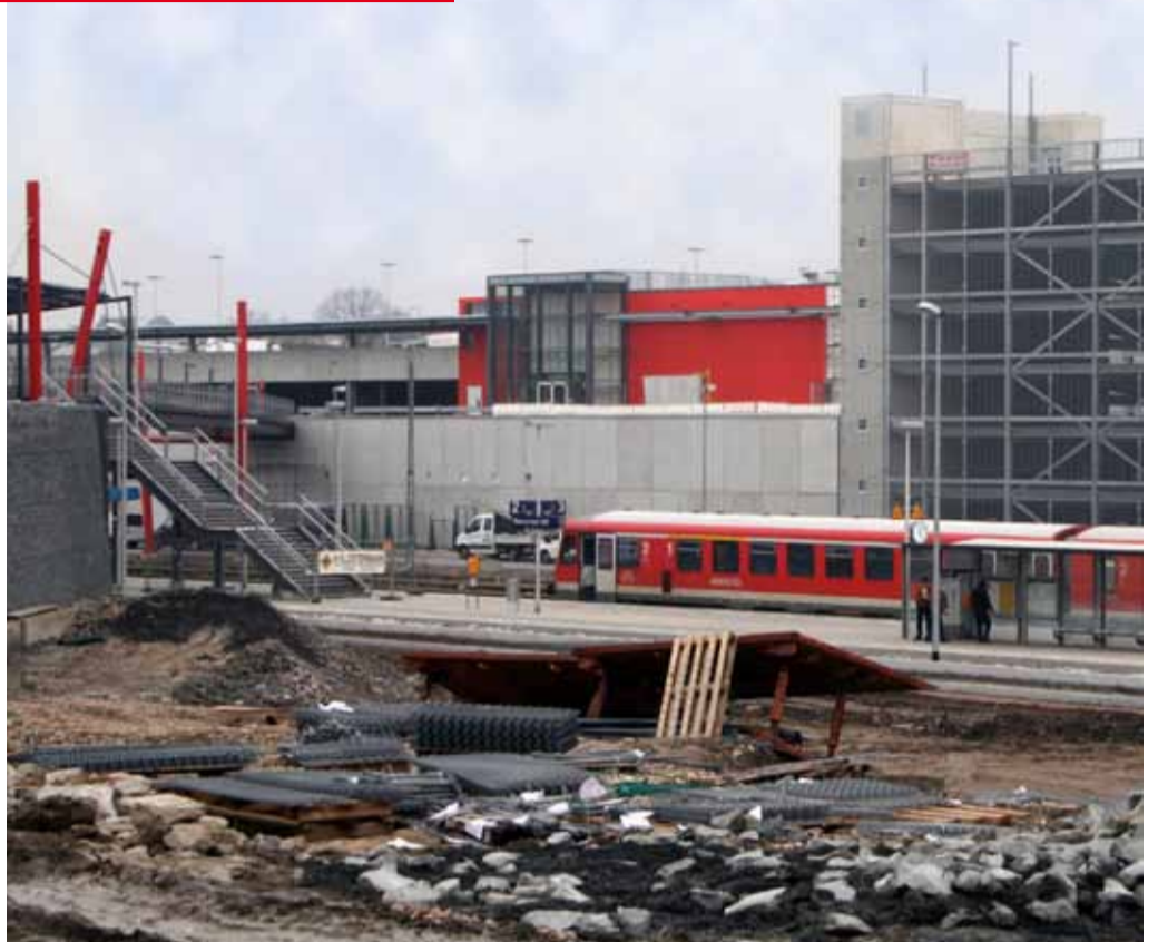
Steg über die Bahngleise mit Treppen- und Aufzugsanlage und rechts das neue Park and Ride Parkhaus.
