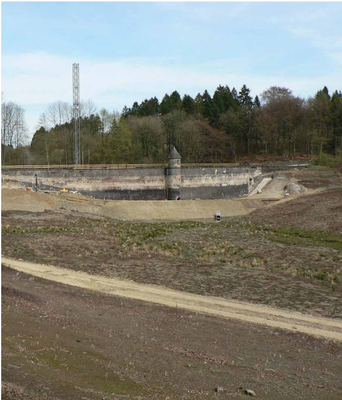
Ein ungewöhnlicher Blick auf die Staumauer der Panzertalsperre. Die Wasserseite des Bauwerks ist für die Bauarbeiten trockengelegt.
