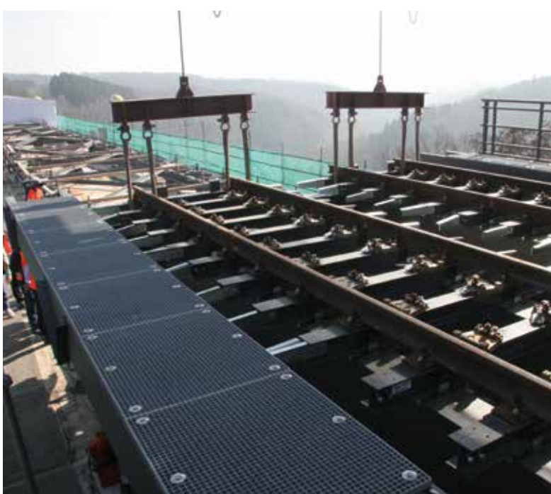
Baustelle in 107 Metern Höhe: Der Fahrweg wird grundlegend erneuert.
